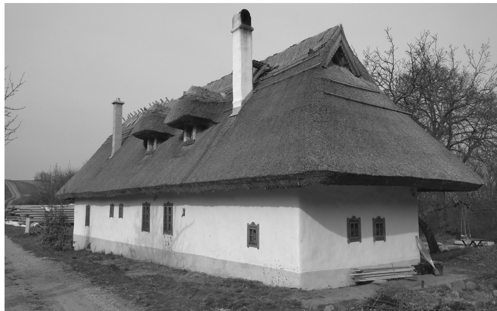
Hrušov. Prestavba objektu s prvkami tradičného staviteľstva. Foto Z. Krišková, 2019
